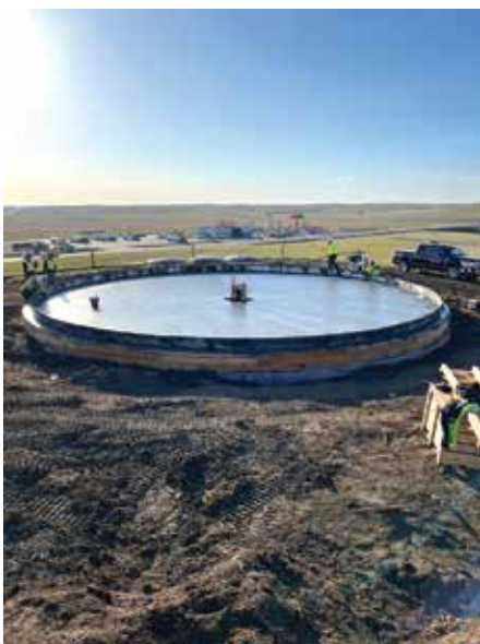
Vivian GSR floor slab.
